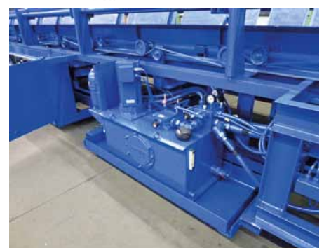
KUVA 4. Esimerkki energiatehokkaasta ratkaisusta teräksen katkaisukoneessa.
