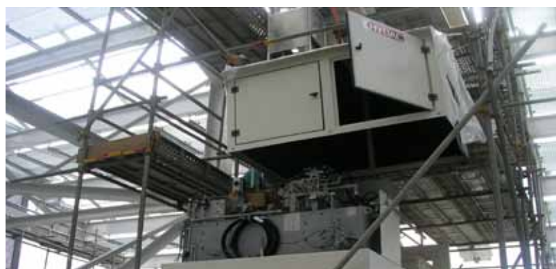
Façade maintenance system with HYDAC power units and cylinders on the Ocean Financial Center in Singapore. Fassadenfahranlage mit HYDAC-Aggregaten und -Zylindern auf dem Ocean Financial Center in Singapur.
